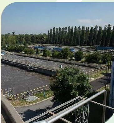
La planta de tratamiento de aguas residuales de Bresso-Niguarda, que forma parte del proyecto de investigación BIOMETHAVERSE, es pionera en Italia en la producción de biometano a partir de lodos de depuradora. Con una capacidad de tratamiento de 2,200 m<sup>3</sup>/h, el agua tratada se reutiliza para la agricultura, mientras que los lodos se someten a digestión anaerobia (DA) para producir biogás. Se inyectan en la red 600,000 m<sup>3</sup>/año de biogás mejorado.
